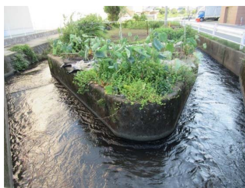
写真7 川尻町まで拡張された川の現状(熊本市南区)
